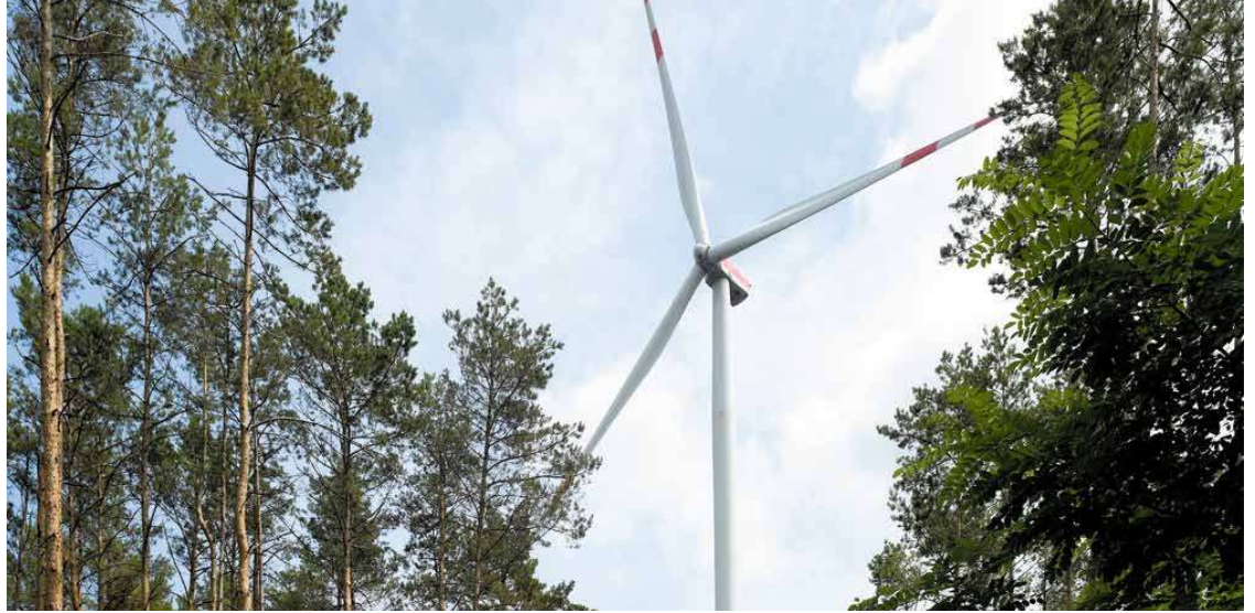
Betonfundamente, so groß wie ein Einfamilienhaus: Windkraftturm im Kreis Teltow-Fläming
