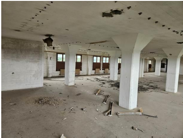
Abbildung 34: Ansicht Speicherbereich 3. OG
