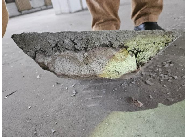
Abbildung 33: Deckenlochverschluss
