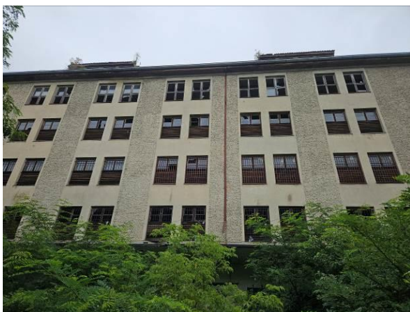
Abbildung 4: Südfassade mit Dehnungsfuge
