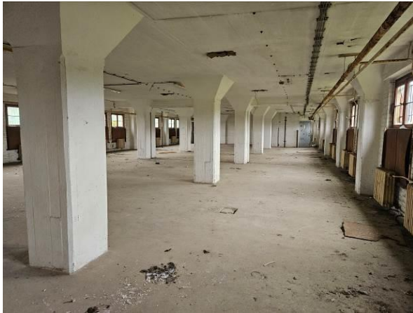
Abbildung 28: Ansicht Speicherbereich 2. OG
