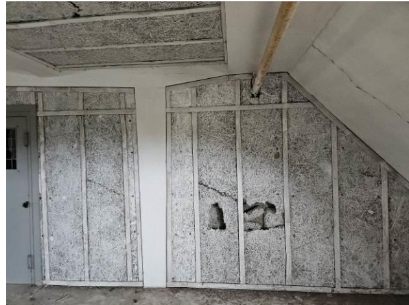
Abbildung 53: Trennwand aus Holzwolle-Leichtbauplatten
