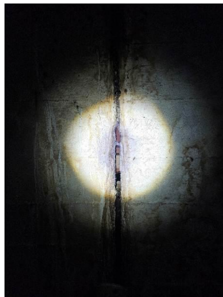
Abbildung 59: Spalt in Dehnungsfuge
