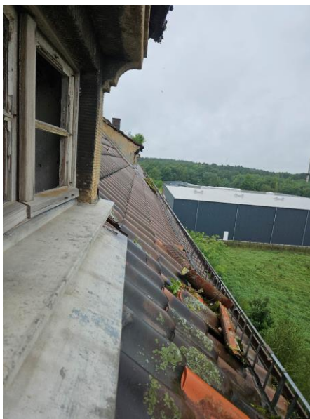
Abbildung 8: Bleche an den Gauben
