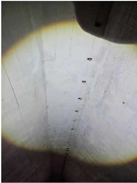
Abbildung 60: Hangplätze an Leitungshaltern
