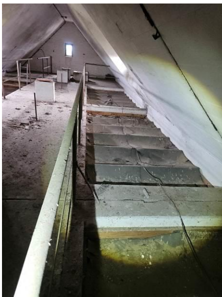
Abbildung 58: abgedeckte Holzwolle-Leichtbauplatten
