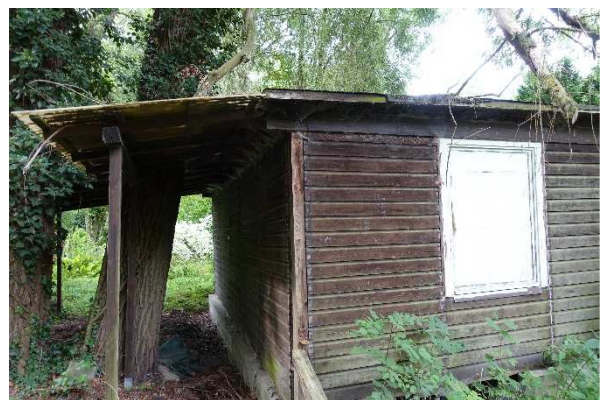
Abbildung 4: Gartenlaube mit Wellblechdach
