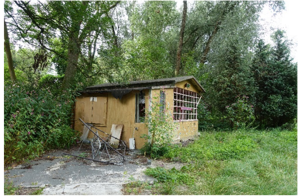
Abbildung 6: Gartenlaube mit offener Fenster- scheibe und Fensterläden
