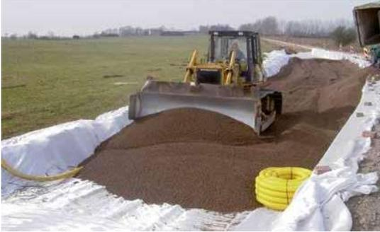
**Bodenaustausch, Einbau Geogitter, Lagenweise Auflast-/ Dammschüttung**
