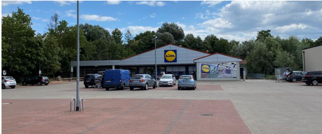
Abbildung 22: Lidl-Lebensmitteldiscounter – Stubenrauchstraße 25a – Ergänzungsstandort Stubenrauchstraße
