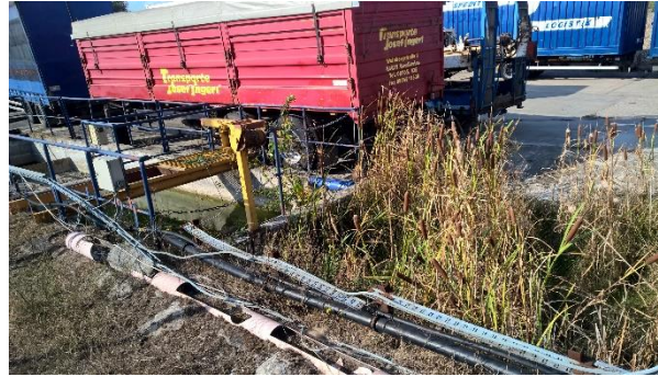
Abbildung 11: Abschnitt 3 (Abwassersammler in Gewerbegebiet)
