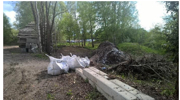
Abbildung 12: Betonbahnschwellen auf dem Gelände der Firma Erdtrans
