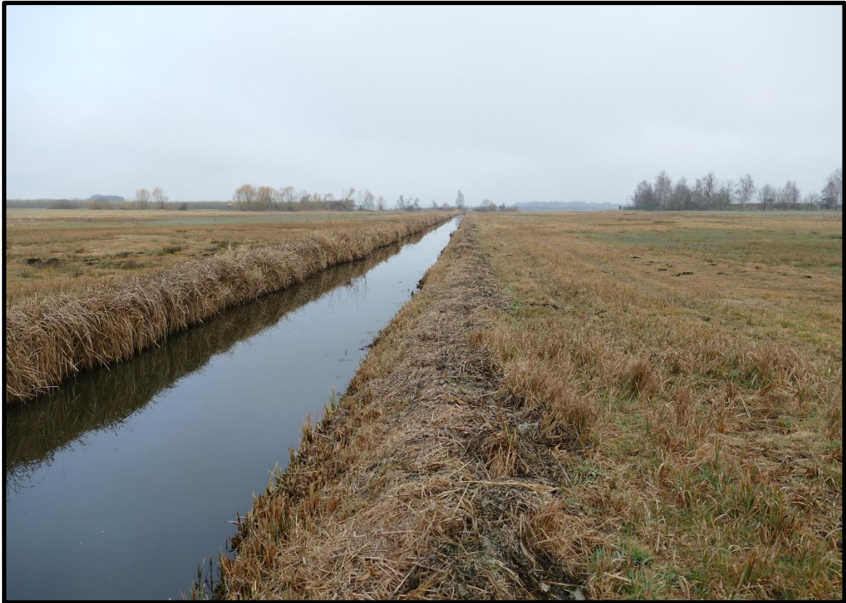
Abbildung 45: Scharf ausgekrazzte Grabenränder, Blickrichtung Nord, das Vorhabengebiet endet etwa an der Baumreihe (13.03.2025, Zaplata).
