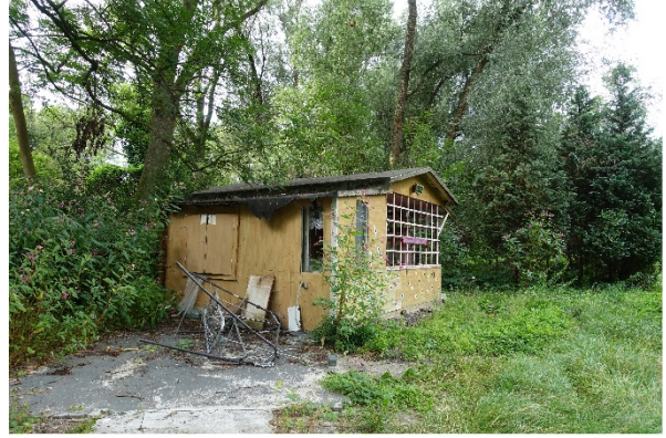
Abbildung 6: Gartenlaube mit offener Fenster- scheibe und Fensterläden
