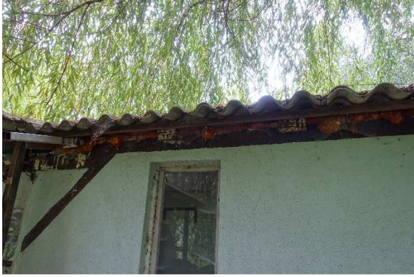
Abbildung 5: Spaltenstrukturen im Dachbereich
