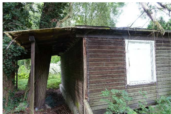
Abbildung 4: Gartenlaube mit Wellblechdach
