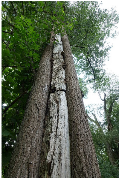
Abbildung 12: Stammschädigung über die gesamte Stammlänge
