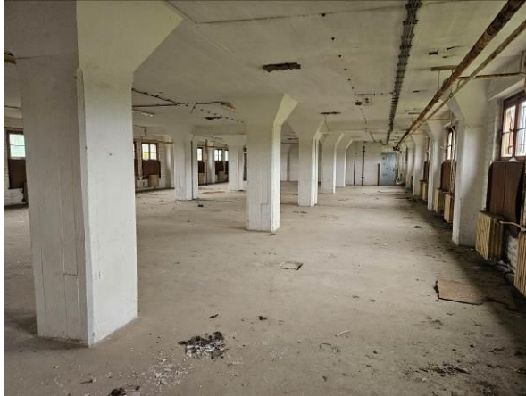
Abbildung 28: Ansicht Speicherbereich 2. OG
