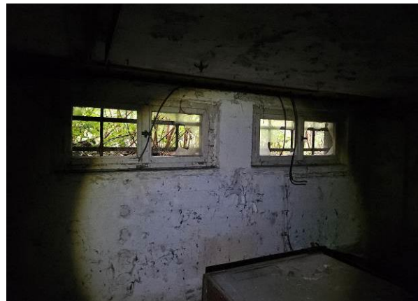
Abbildung 15: offene Fenster kurz oberhalb des anstehenden Geländes
