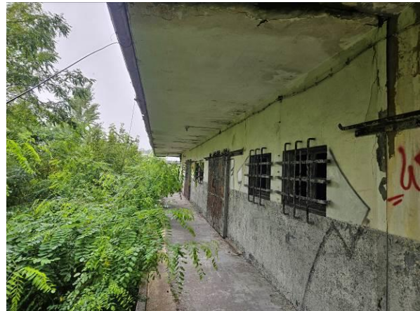
Abbildung 7: Überdachte Laderampe mit angrenzendem Robinienaufwuchs an der Südseite
