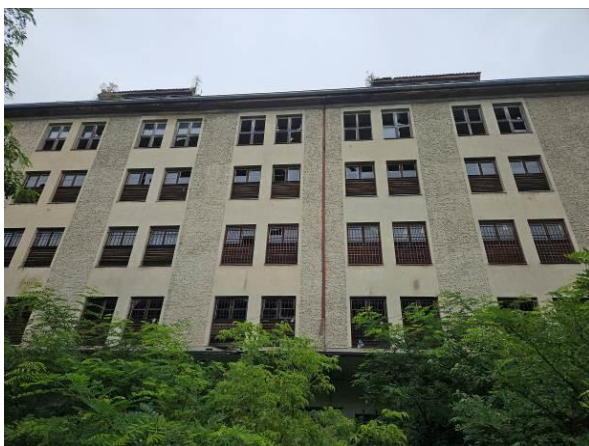
Abbildung 4: Südfassade mit Dehnungsfuge
