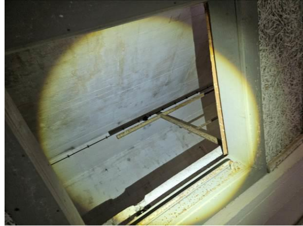
Abbildung 57: Einstiegs Luke Blick vom Dachgeschoss in den Dachboden
