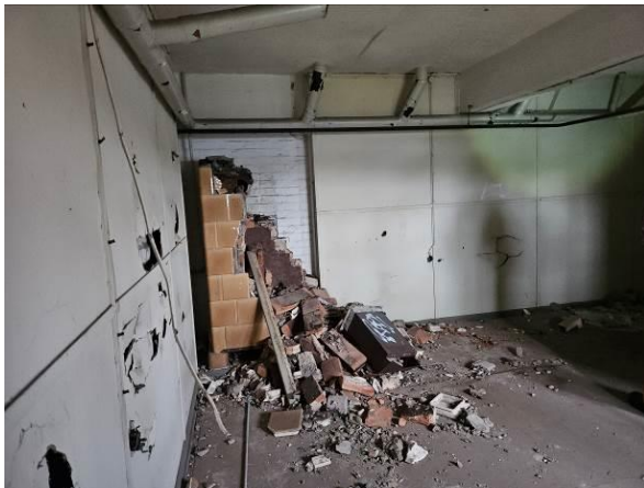
Abbildung 26: Raum mit Wandverkleidung
