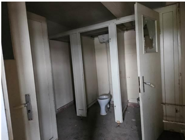
Abbildung 30: abgetrennter Bereich mit Toiletten
