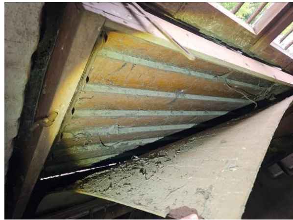
Abbildung 25: teilweise offene Lüftungsclappenverkleidung
