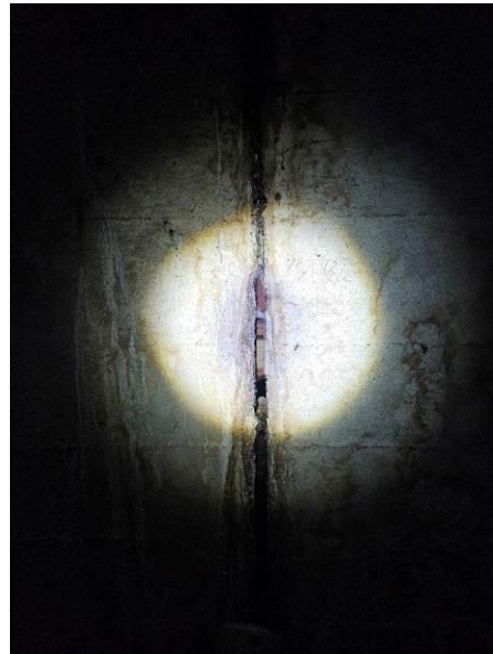
Abbildung 59: Spalt in Dehnungsfuge
