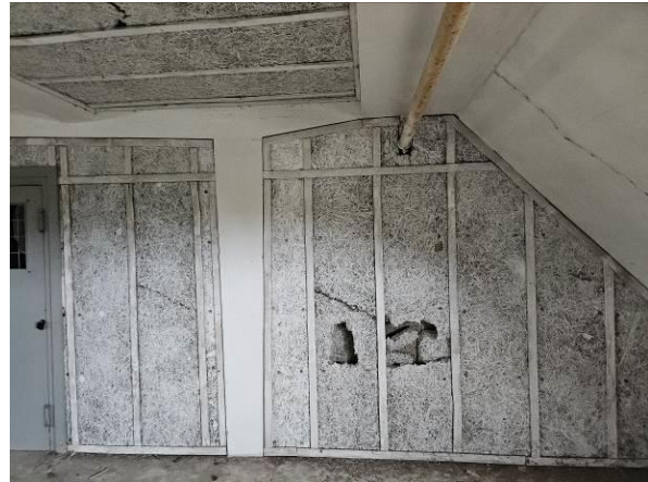
Abbildung 53: Trennwand aus Holzwolle-Leichtbauplatten
