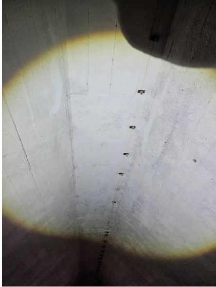
Abbildung 60: Hangplätze an Leitungshaltern
