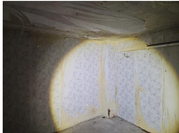
Abbildung 19: Abgetrennter Raum mit Wandverkleidung und Tapete
