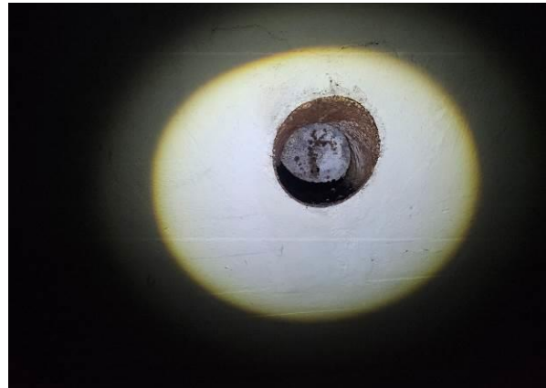
Abbildung 11: Metallrohr in der Decke, oben verschlossen; potentieller Fledermaushangplatz
