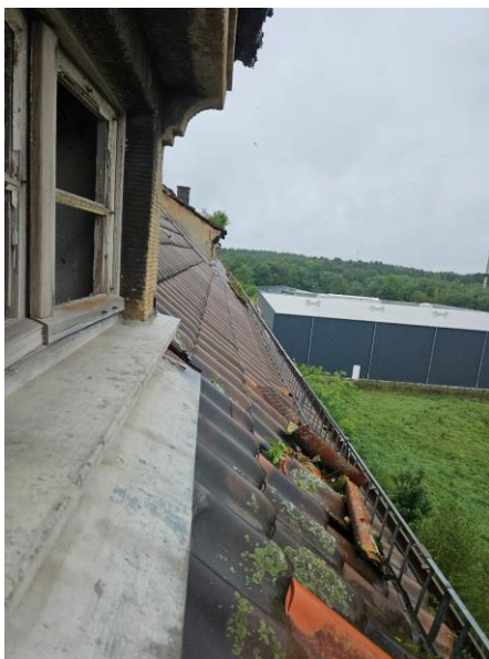
Abbildung 8: Bleche an den Gauben
