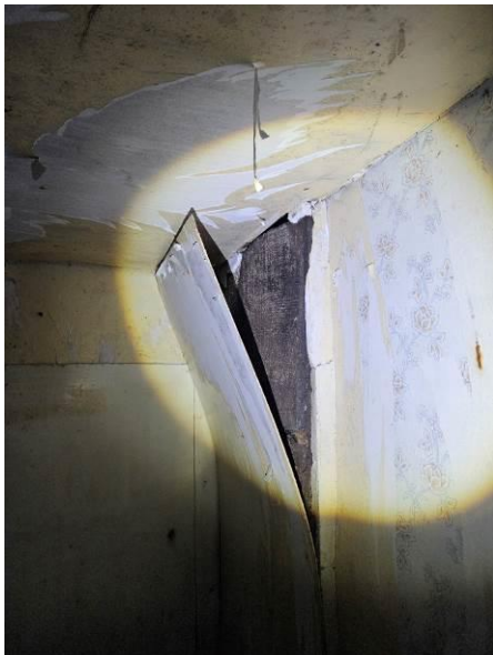
Abbildung 18: Abgetrennter Raum mit Wandverkleidung und Tapete
