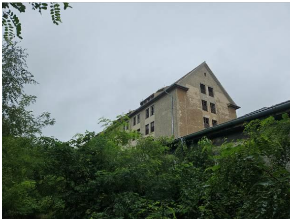
Abbildung 2: Südostansicht mit dichtem Robienaufwuchs
