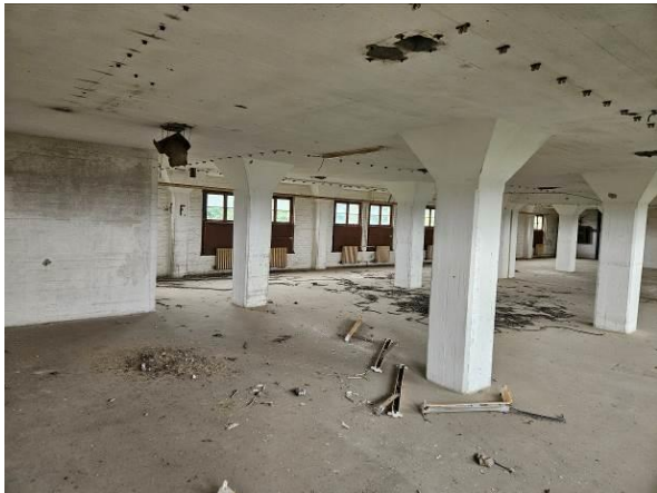
Abbildung 34: Ansicht Speicherbereich 3. OG
