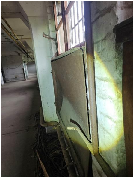
Abbildung 24: Fenster (oben) und Lüftungsclappen (unten)
