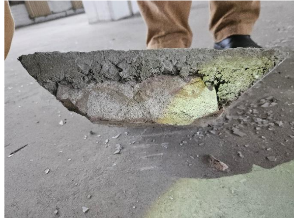
Abbildung 33: Deckenlochverschluss
