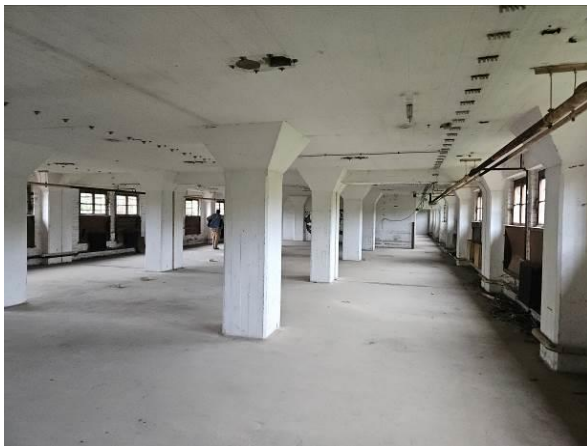
Abbildung 22: Ansicht Speicherbereich 1. OG
