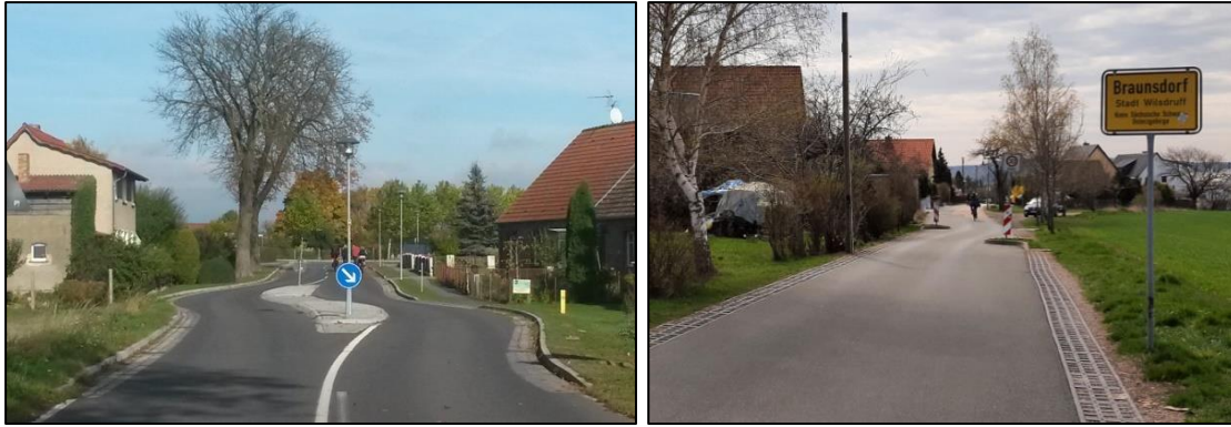
Abb. 15 Beispiele Ortseingangsgestaltung mit Fahrstreifenversatz
