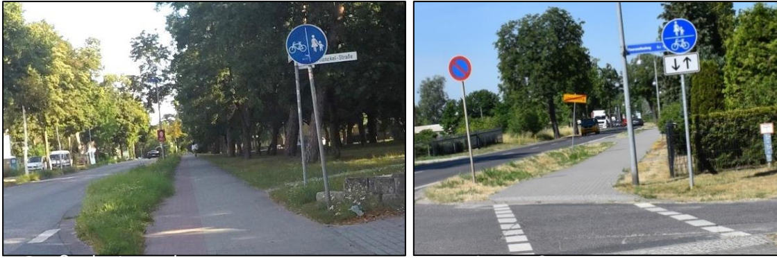
Abb. 3 Bestandssituation Radverkehrsanlagen im Stadtgebiet
