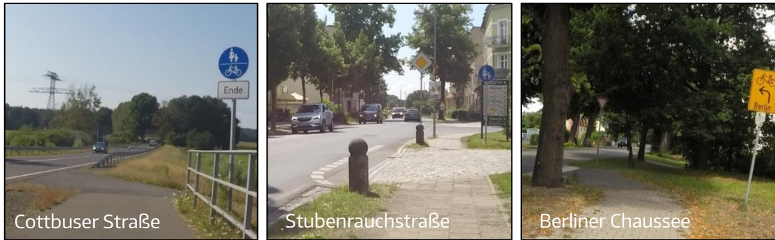
Abb. 8 Bestandssituation Anschlussbereiche bestehender Radverkehrsanlagen
