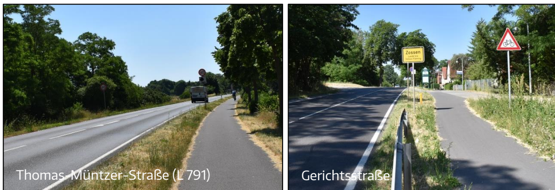
Abb. 5 Bestandssituation Radwege im Außenbereich
