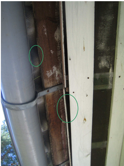
Abbildung 5: Mögliche Einflugöffnungen für Fledermäuse unterhalb der Dachtraufen
