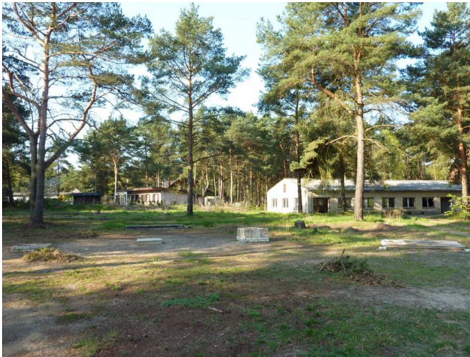
Abbildung 8: Südliche Grundstücksbegrenzung mit altem Speisesaal (Objekt 18)
