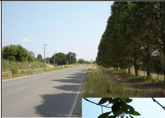
Bild 1 Zufahrt Deponie und Gleisanschluss
