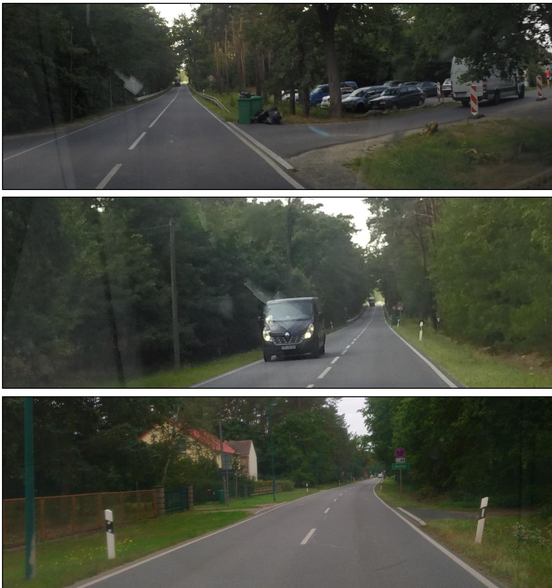
Abb. 2: Bestandssituation Schünower Straße (B 246)
