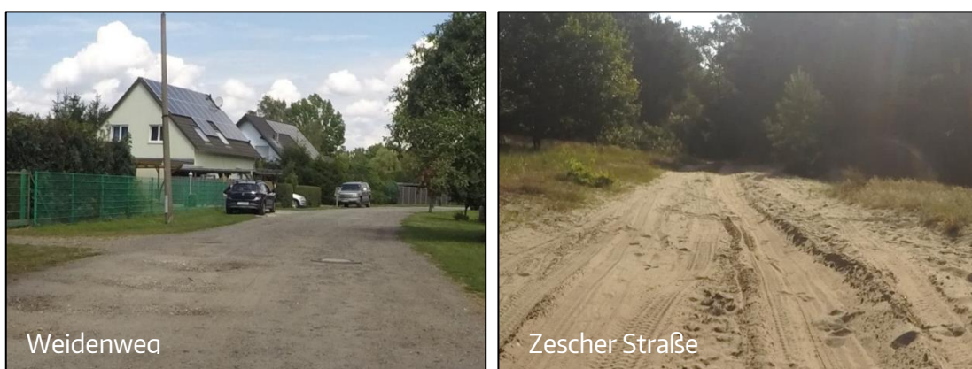
Abb. 12 Beispiele Oberflächendefizite im Nebennetz
