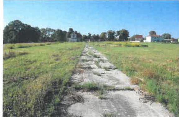
Abbildung 3: Nördliches UG - Blick nach Süden
