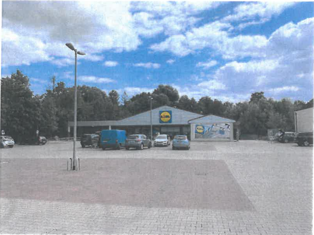
Abbildung 19: Lidl-Lebensmitteldiscounter - Stubenrauchstraße 25a - Zossen (Ergänzungsstandort Stubenrauchstraße)
