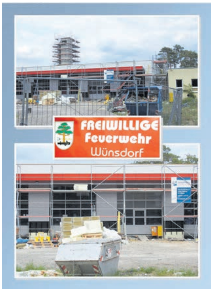
Die Baustelle in Wünsdorf.
