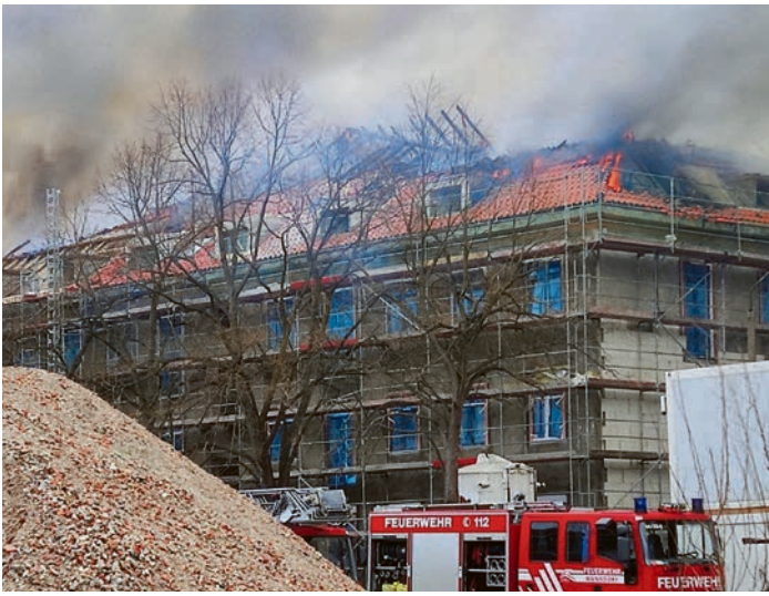
Der Dachstuhl des leerstehenden Wohnblock in der ehemaligen sowjetischen Kaserne in Wünsdorf ist am Donnerstag, dem 15. April, vollständig abgebrannt. Foto: Freiwillige Feuerwehr Zossen
