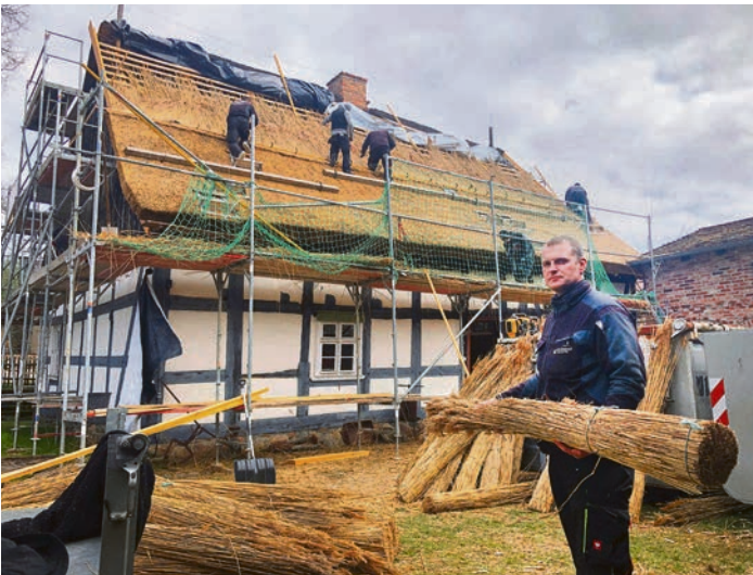
Dachdeckermeister Daniel Girke mit einem Schilfbündel. Dieses Material wird bei der traditionellen Reetbedachung verwendet. 250 Quadratmeter Dach am Heimatmuseum „Alter Krug“ wurden mit dieser alten Technik neu eingedeckt. Fotos: Stadt Zossen
